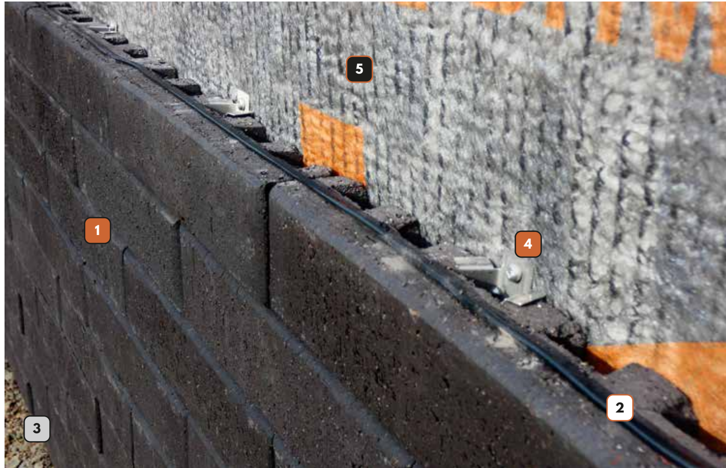
PRÉCISION DANS CHAQUE COURS» Installation sans mortier avec Heritage Dry-Stack, Slate.
